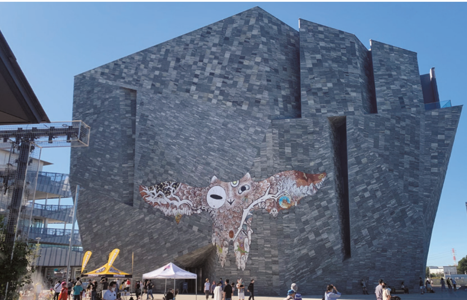
角川武蔵野ミュージアム／所沢市
